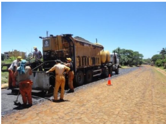
Figura 5. Equipo de colocación utilizado en el tramo experimental
