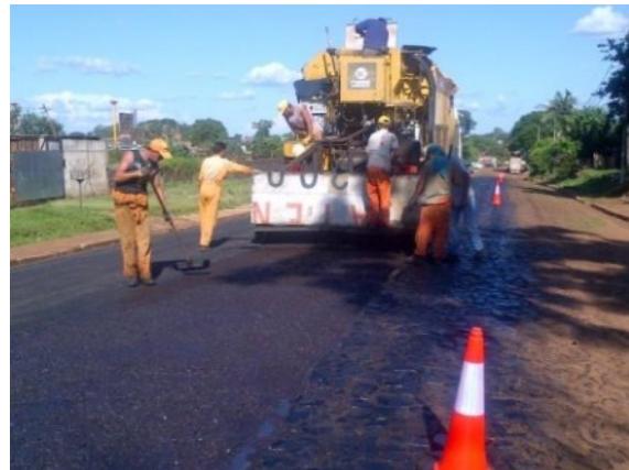
Figura 5. Equipo de colocación utilizado en el tramo experimental
